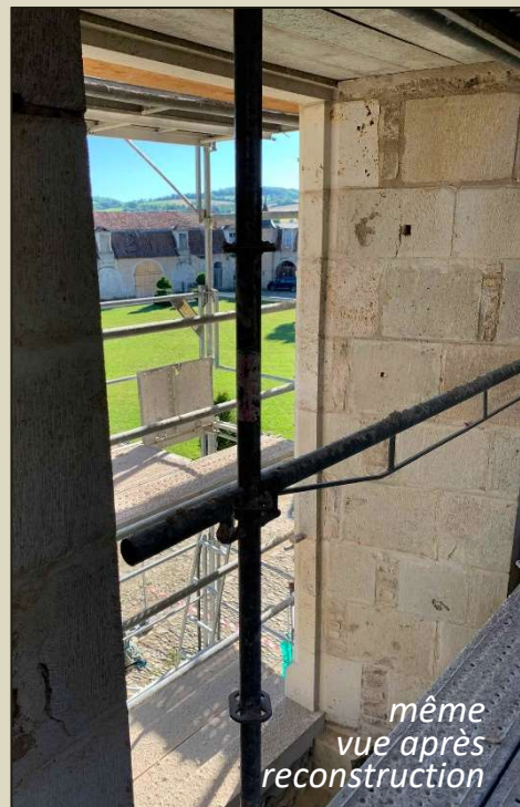
vue en cours de travaux brèche ouverte
